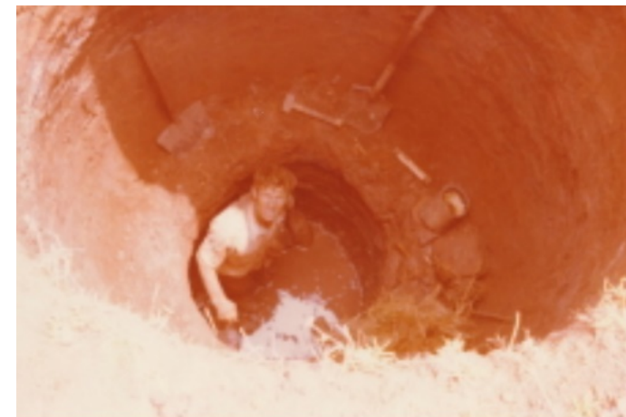
Scavo pozzo per dispensario sull'isola di Ibinja
