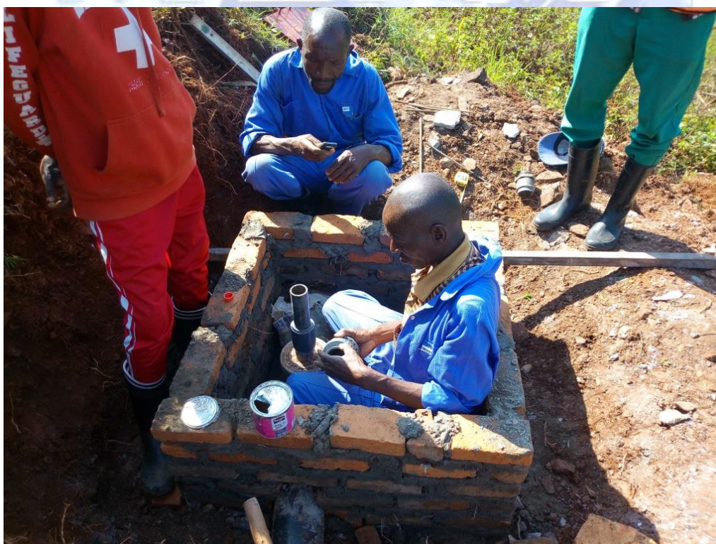
Camera di comando condotte
