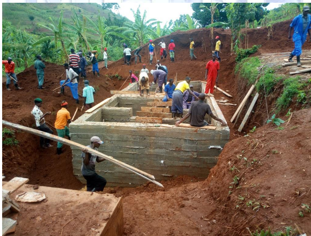
Muri in cemento armato delle vasche della stazione di trattamento
