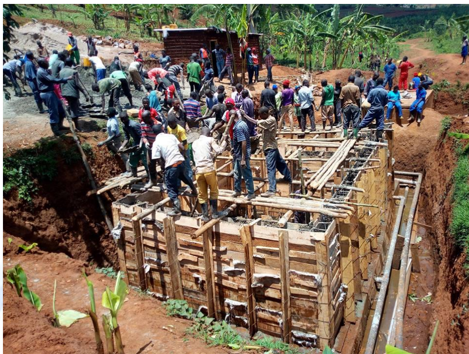
Getto dei muri di elevazione della stazione di trattamento
