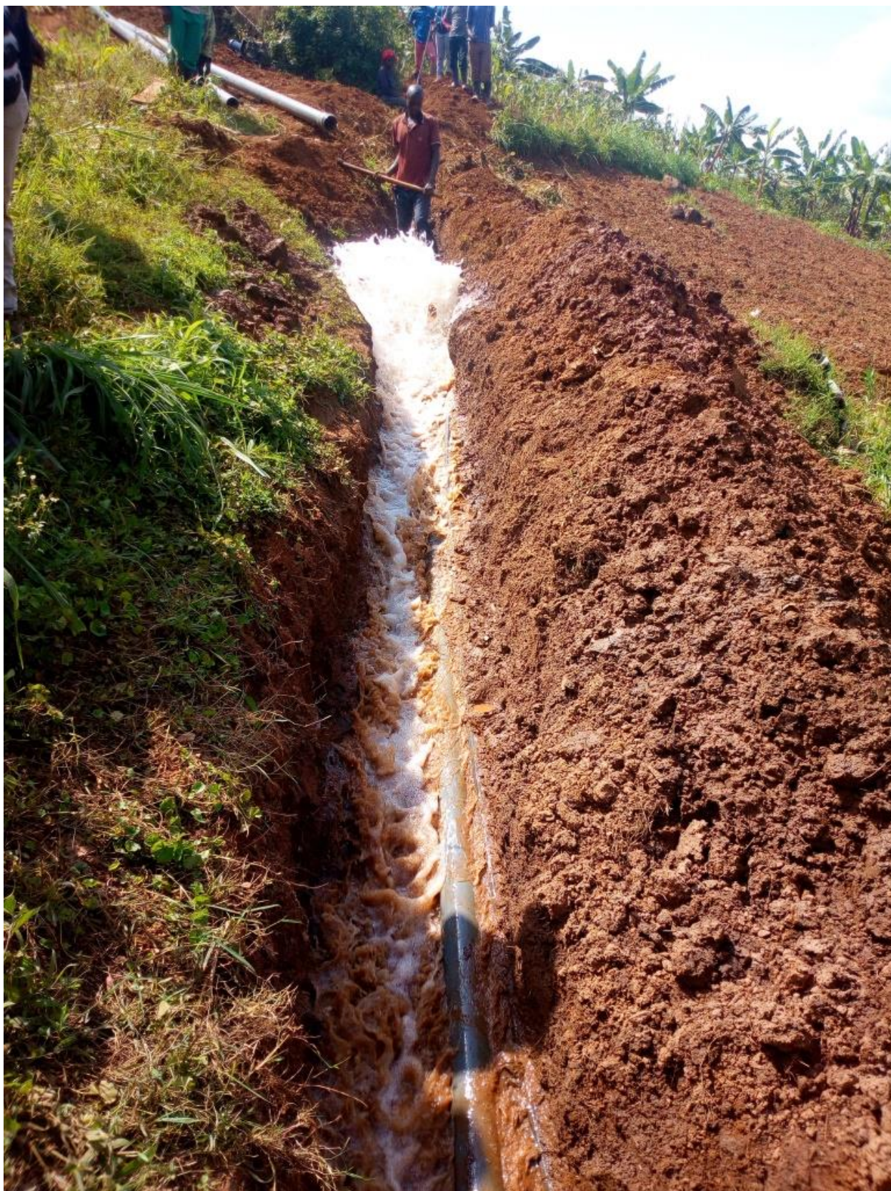
Scavi e test della condotta principale per verificare perdite e portate
