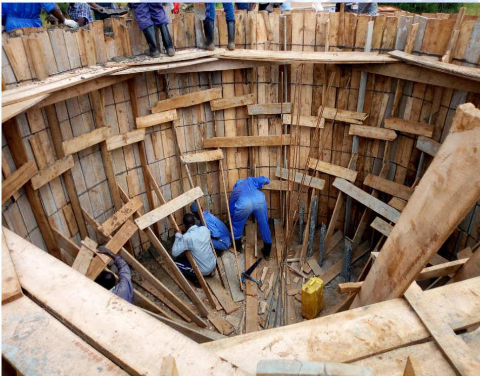
Interno dei casseri della nuova riserva da 60'000 Litri
