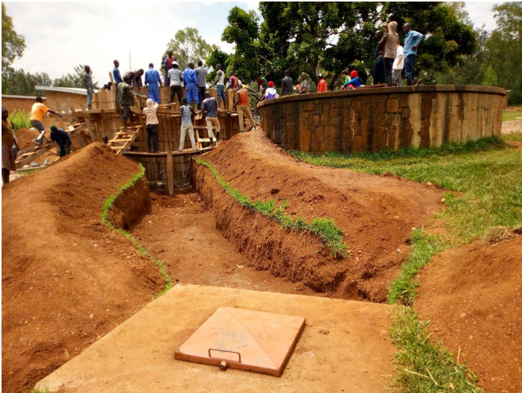
Vecchia riserva con a fianco la nuova in C.A. da 60'000 Litri durante il getto
