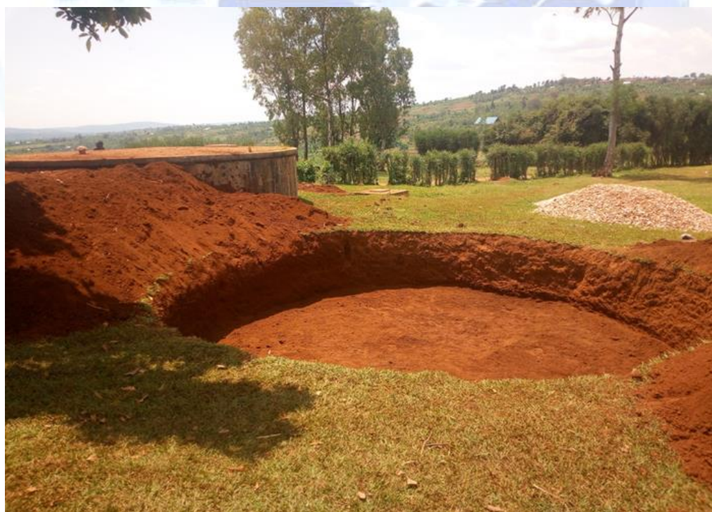
Scavo di fondazione per nuova riserva 60'000 Litri
