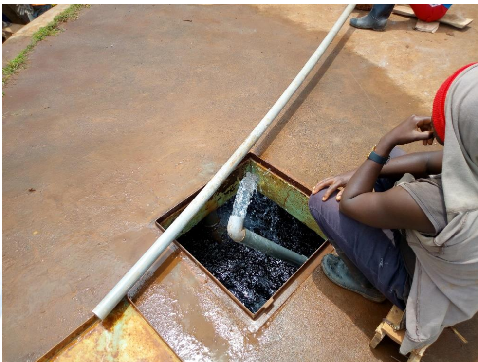
Alcune fasi dei test di portata e verifica delle condotte e riserve esistenti
