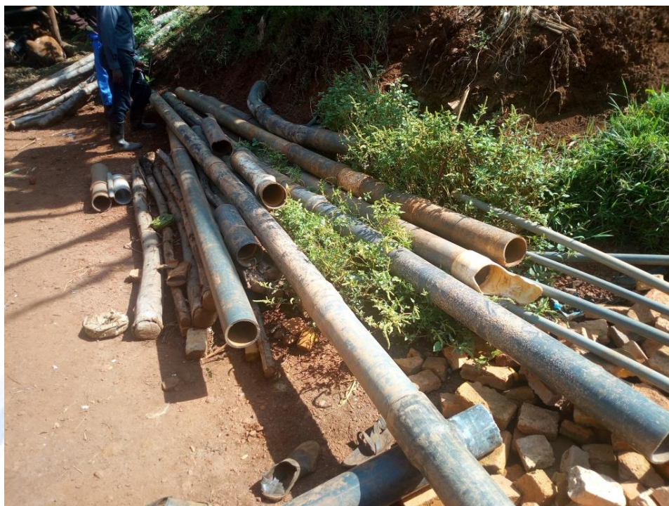
Alcuni dei tubi sostituiti
