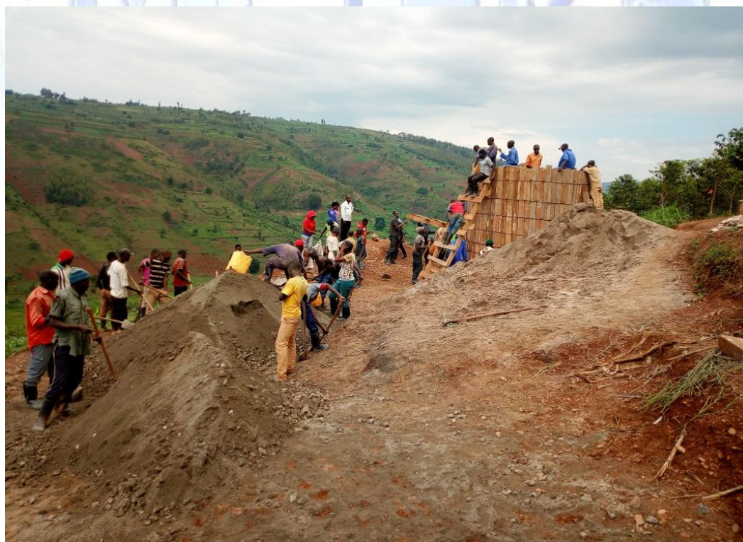
Costruzione nuova riserva in C.A. da 15'000 Litri
