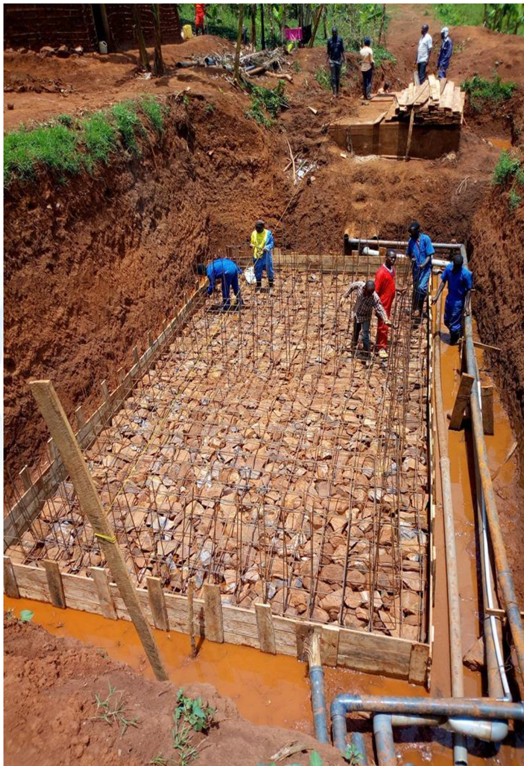
Fondazioni della stazione di trattamento con sistema di filtraggio quarzo e travertino
