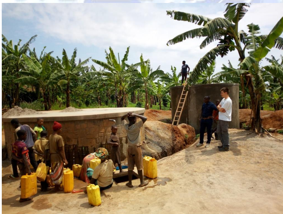
Vecchia riserva da demolire con a fianco la nuova in C.A. da 30'000 Litri
