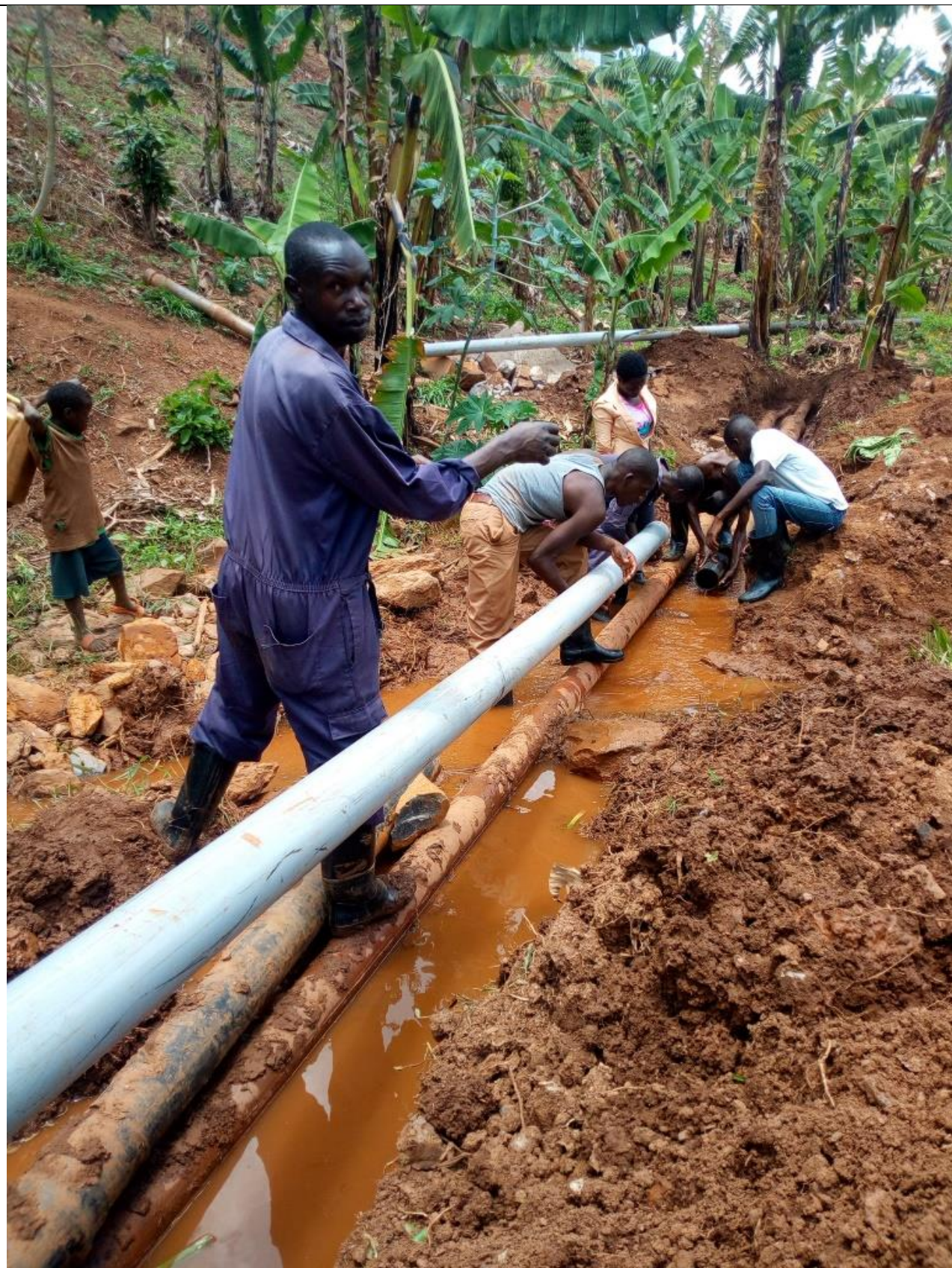
Riparazione condotta principale inguainata in tubo acciaio
