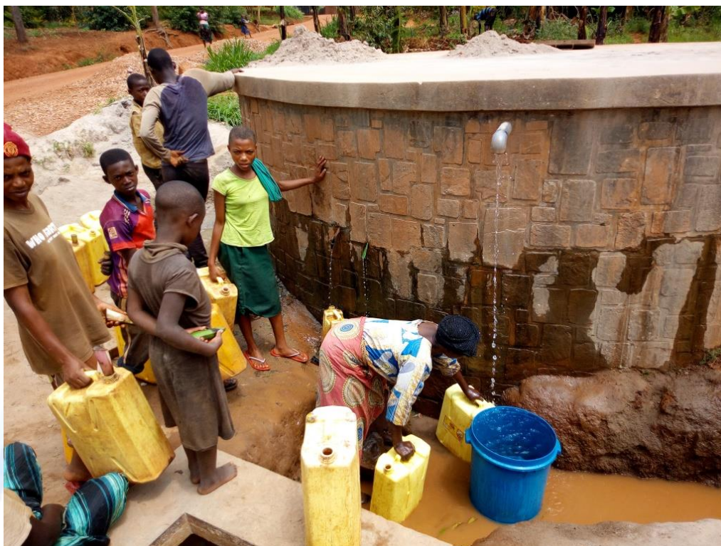
Test di tenuta di vecchia riserva
