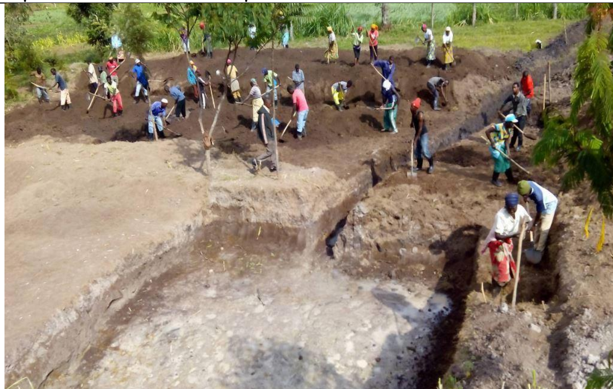
Scavi per riserva e stazione di trattamento
