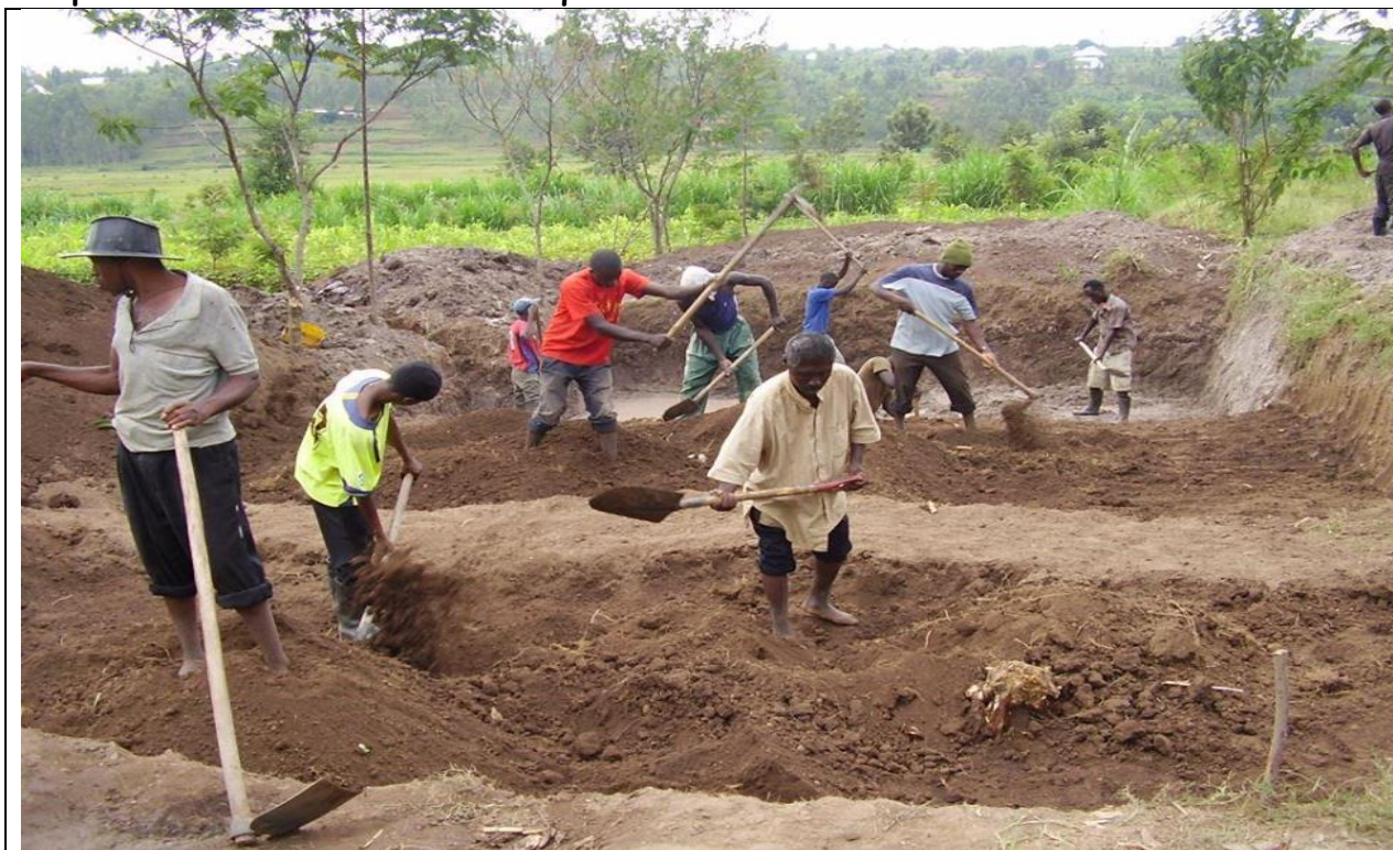
Scavi per riserva e stazione di trattamento
