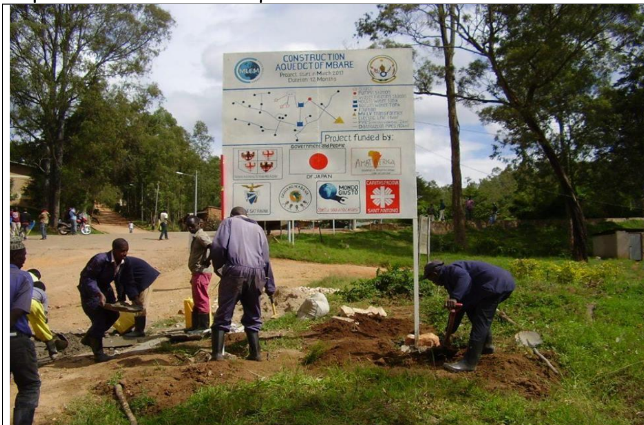
Installazione pannelli di visibilità
