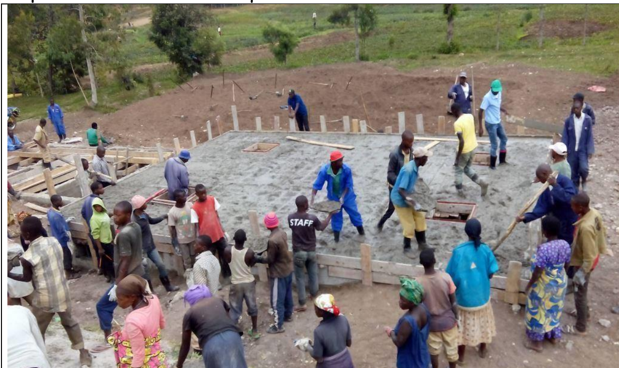
Costruzione di riserva e stazione di trattamento
