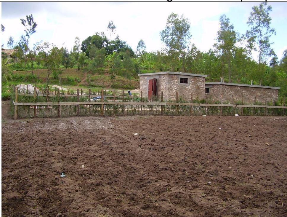
Riserva da 40'000 litri, magazzino sala pompe e stazione trattamento
