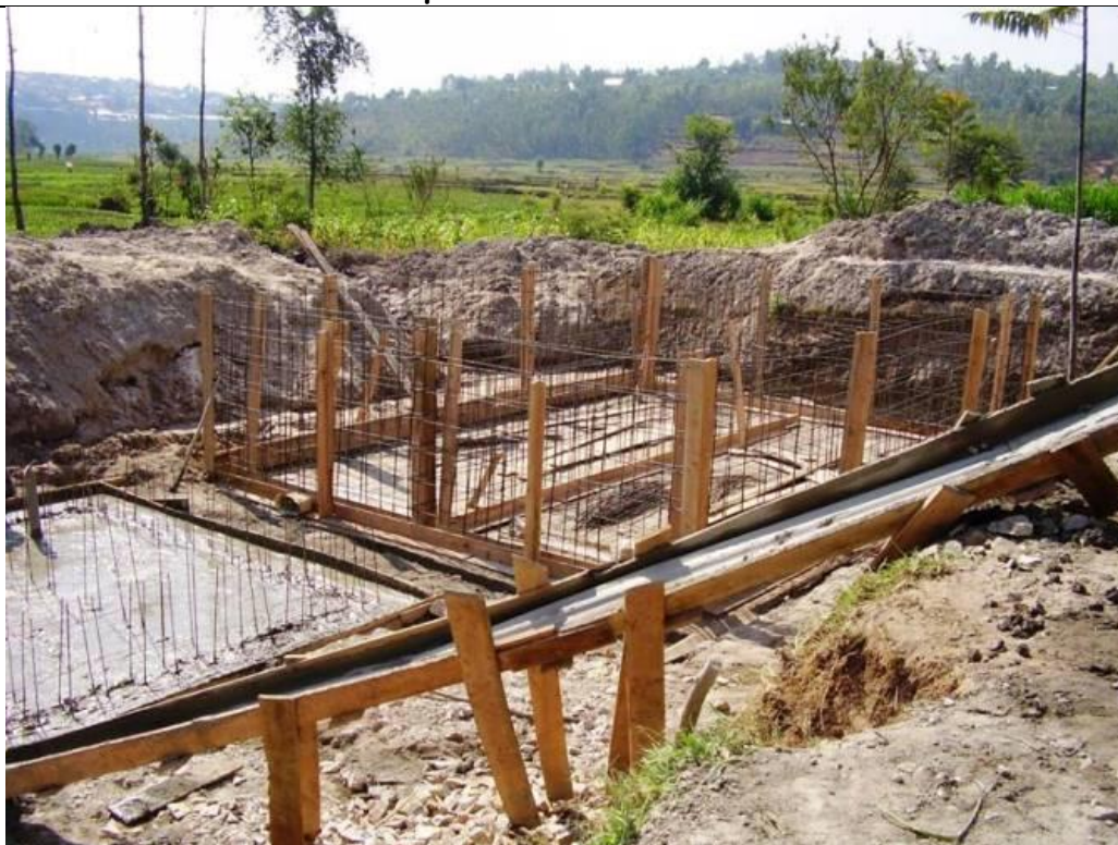
Costruzione di riserva e stazione di trattamento
