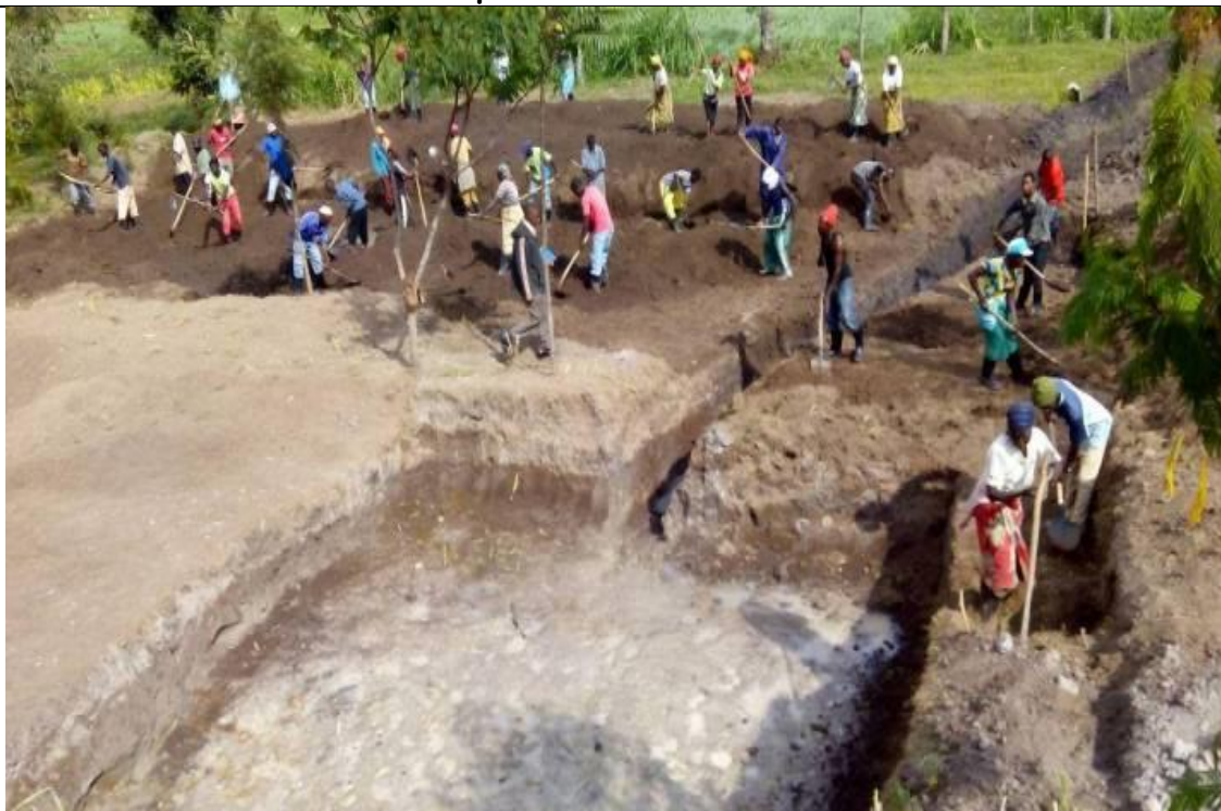
Scavi per riserva e stazione di trattamento
