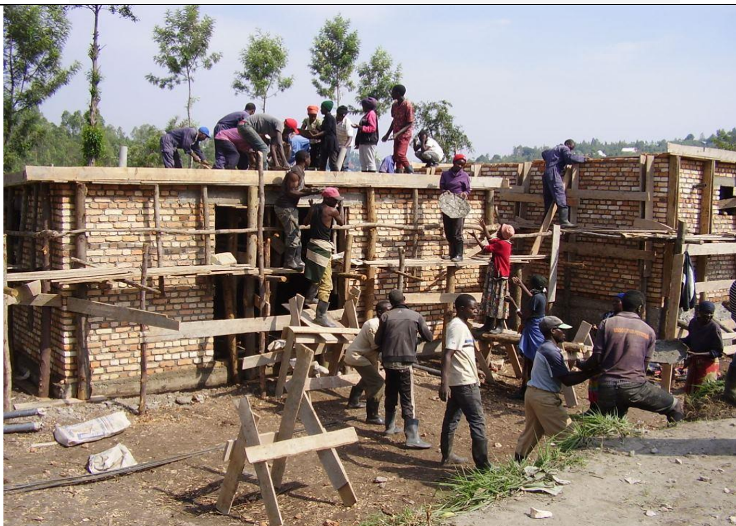
Costruzione di riserva e stazione di trattamento
