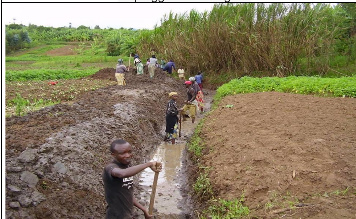
Captaggio delle sorgenti
