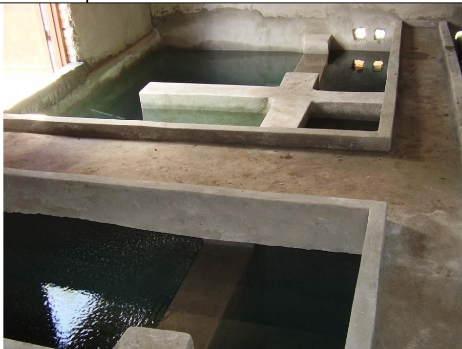
Test impermeabilità delle vasche di trattamento
