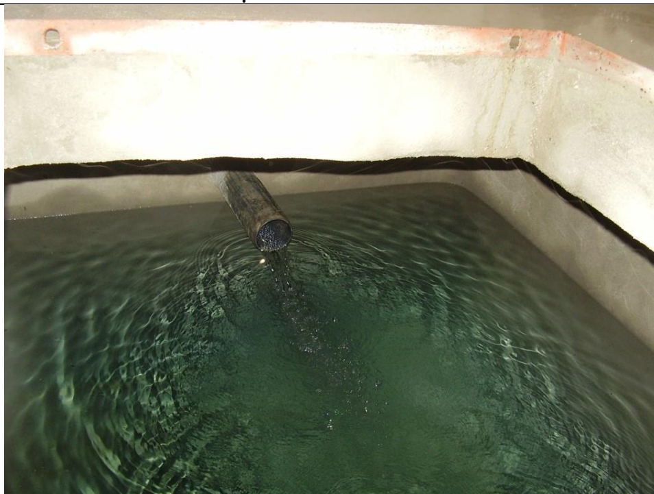
Test impermeabilità delle vasche di trattamento
