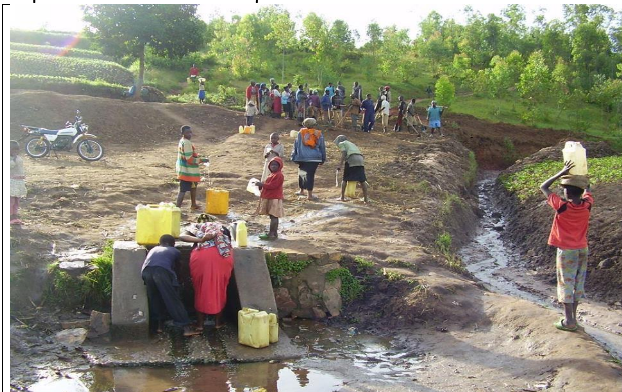
Captaggio delle sorgenti
