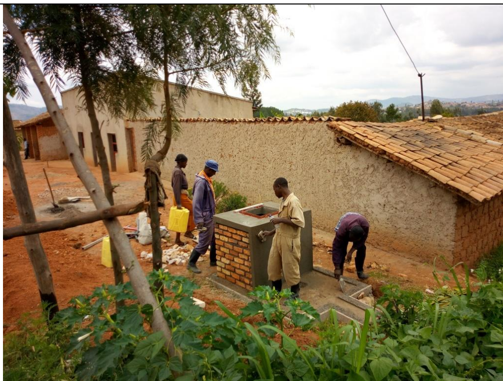
Costruzione di una fontana
