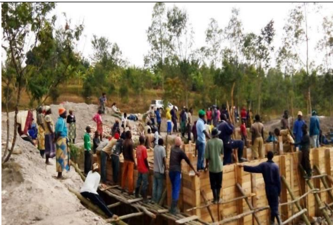
Costruzione di riserva e stazione di trattamento
