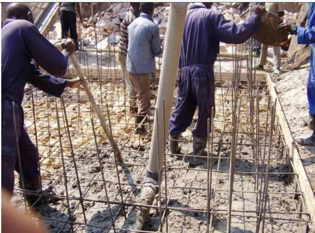
Costruzione di riserva e stazione di trattamento
