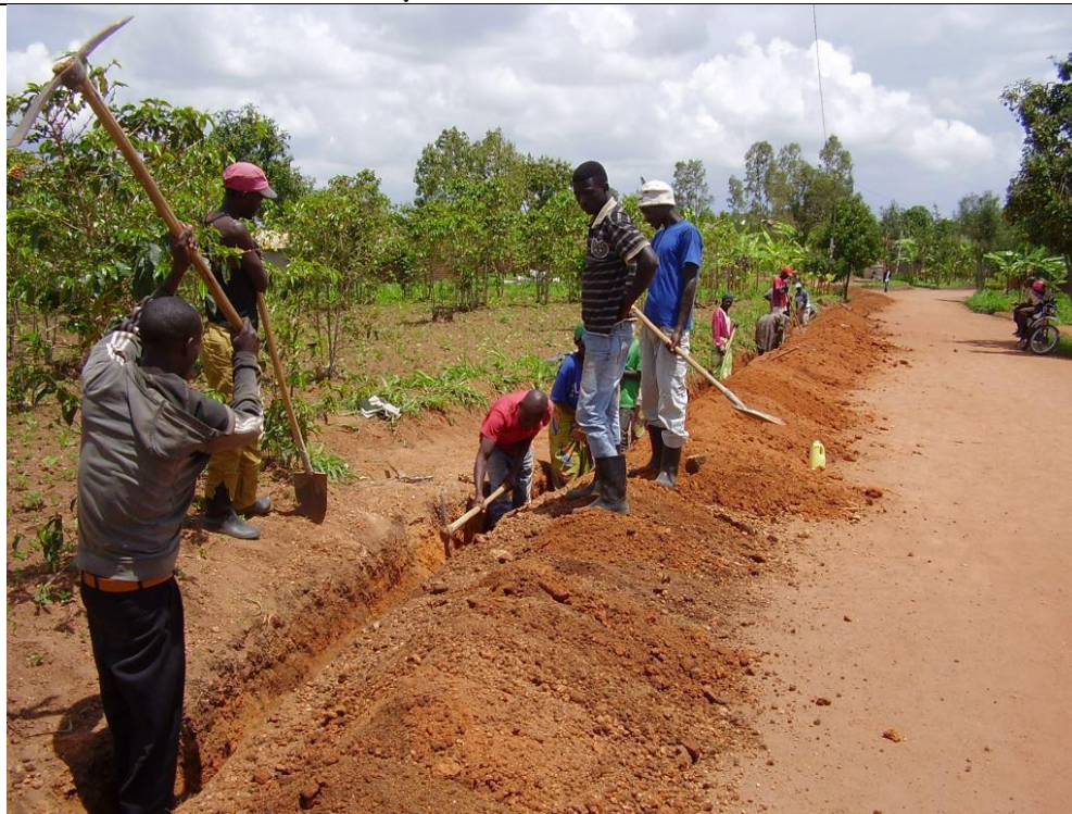
Scavi trincee per distribuzione
