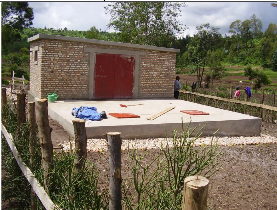
Riserva da 40'000 litri e magazzino sala pompe
