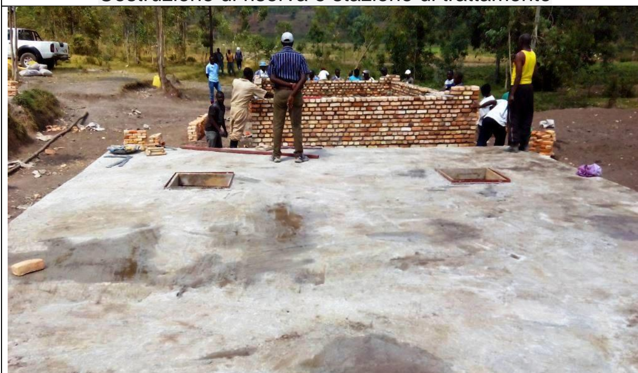
Costruzione di riserva e stazione di trattamento
