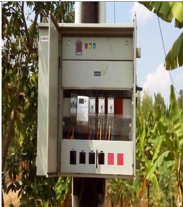
Visita alla linea elettrica esistente
