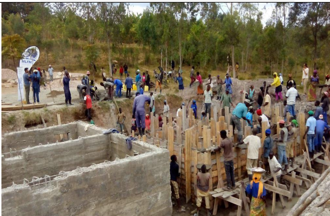
Costruzione di riserva e stazione di trattamento
