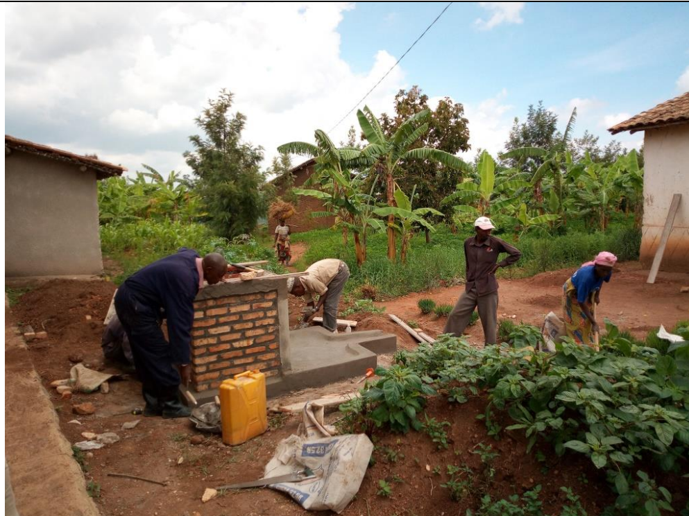
Costruzione di una fontana
