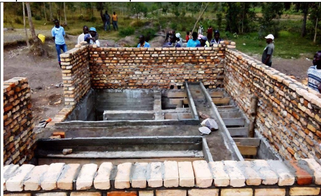
Costruzione di riserva e stazione di trattamento
