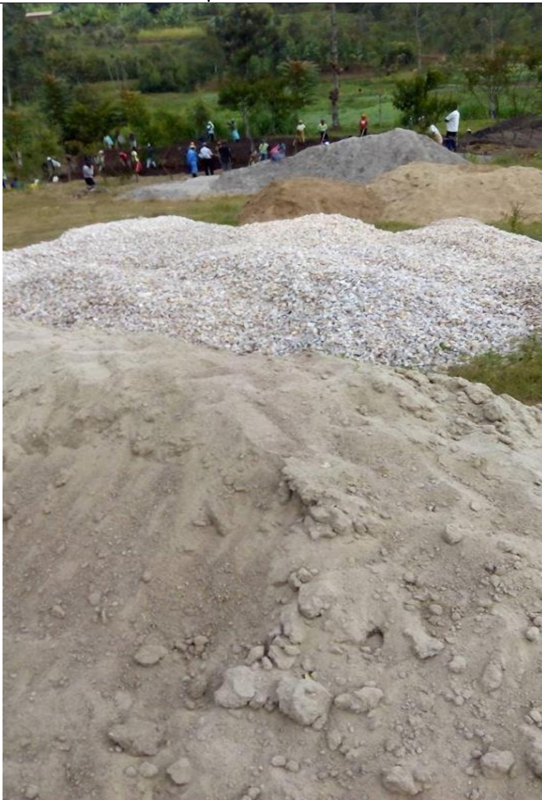
Dposito dei materiali inerti
