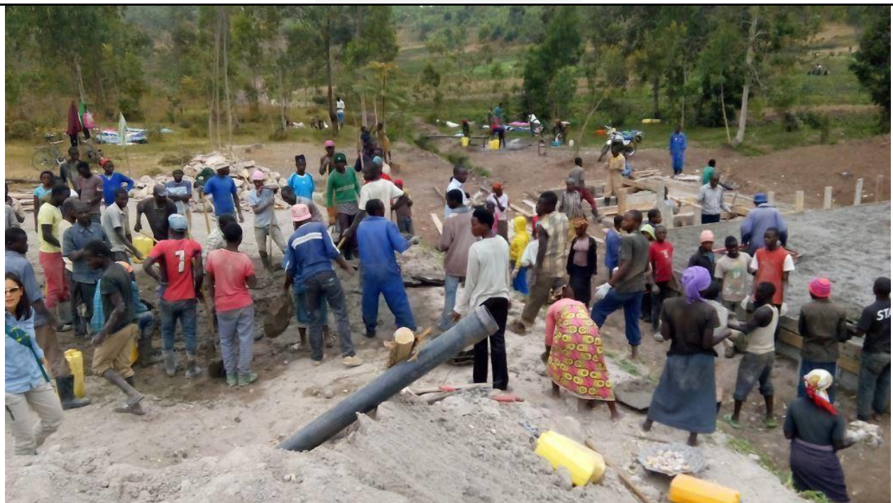
Costruzione di riserva e stazione di trattamento
