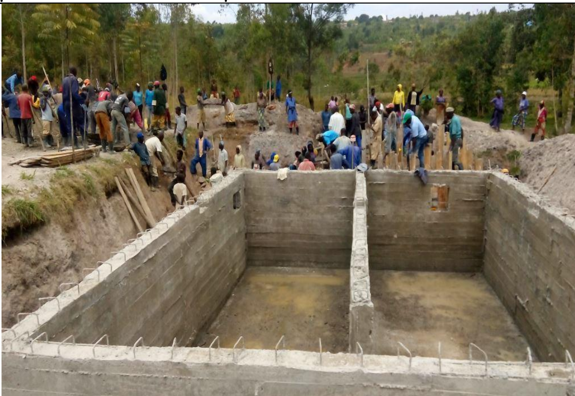
Costruzione di riserva e stazione di trattamento
