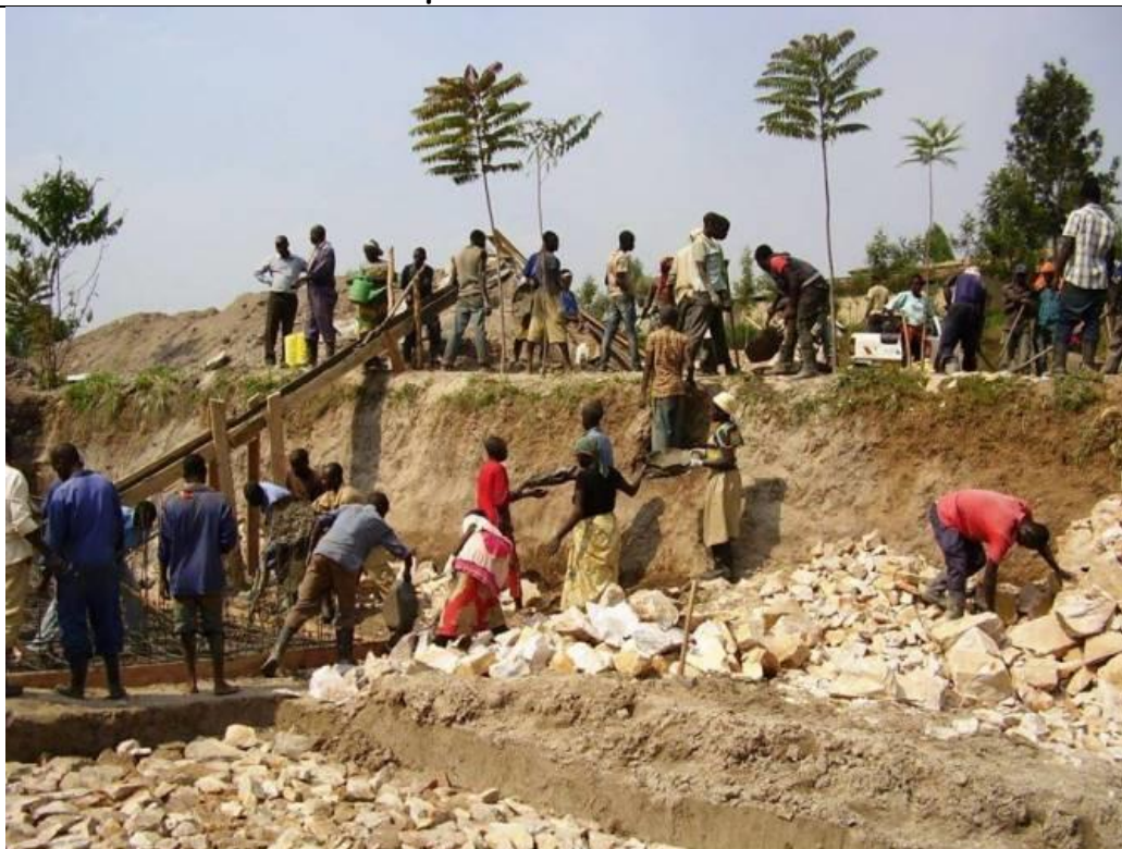
Costruzione di riserva e stazione di trattamento
