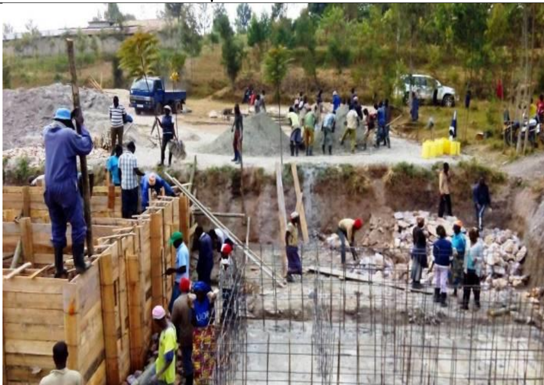
Costruzione di riserva e stazione di trattamento
