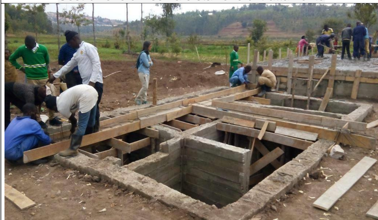
Costruzione di riserva e stazione di trattamento
