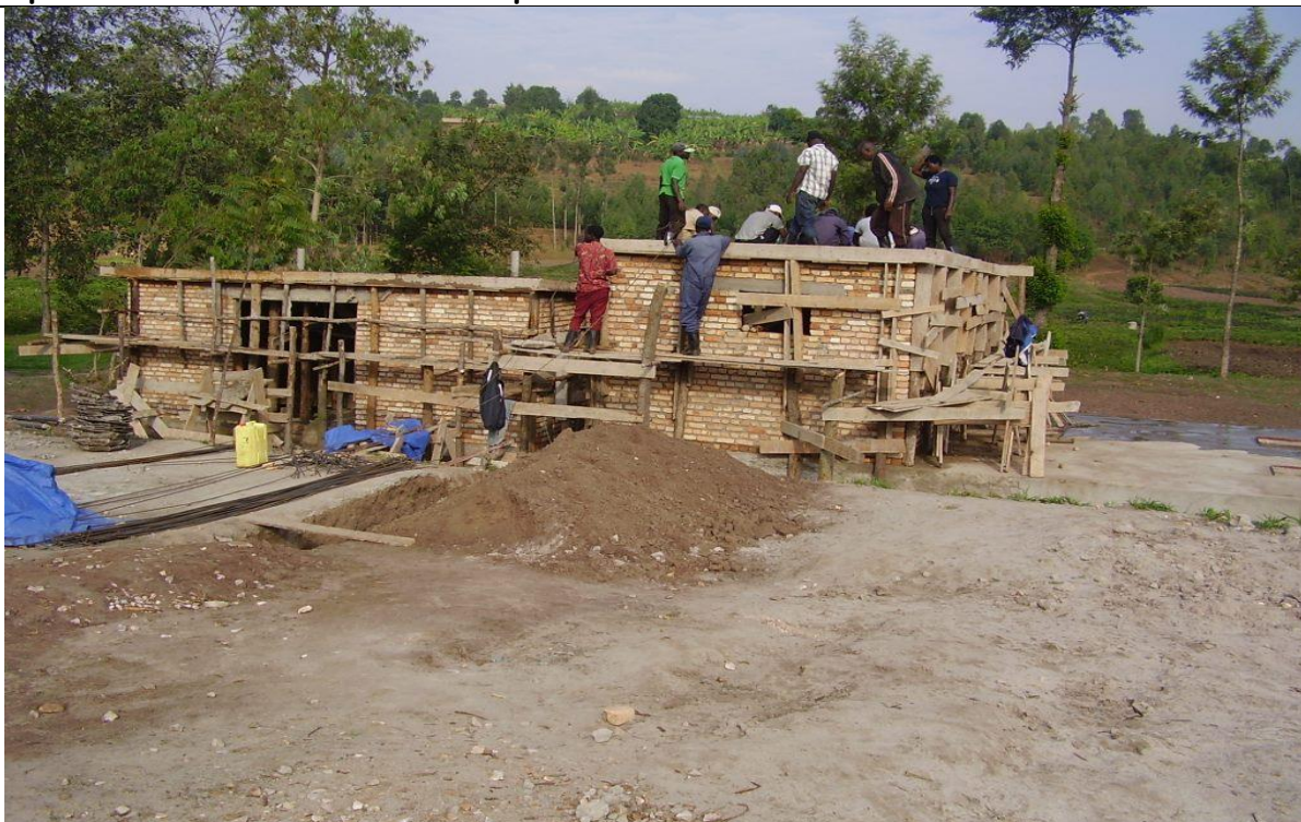
Costruzione di riserva e stazione di trattamento
