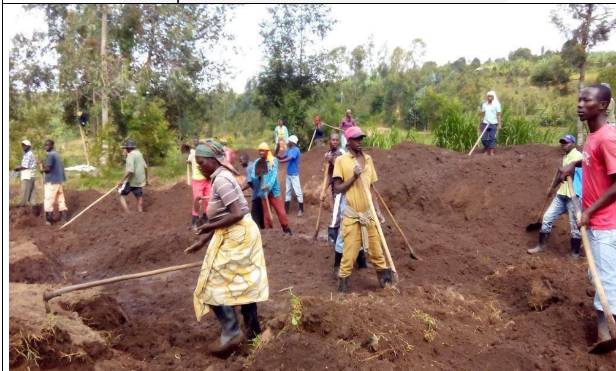
Scavi per riserva e stazione di trattamento
