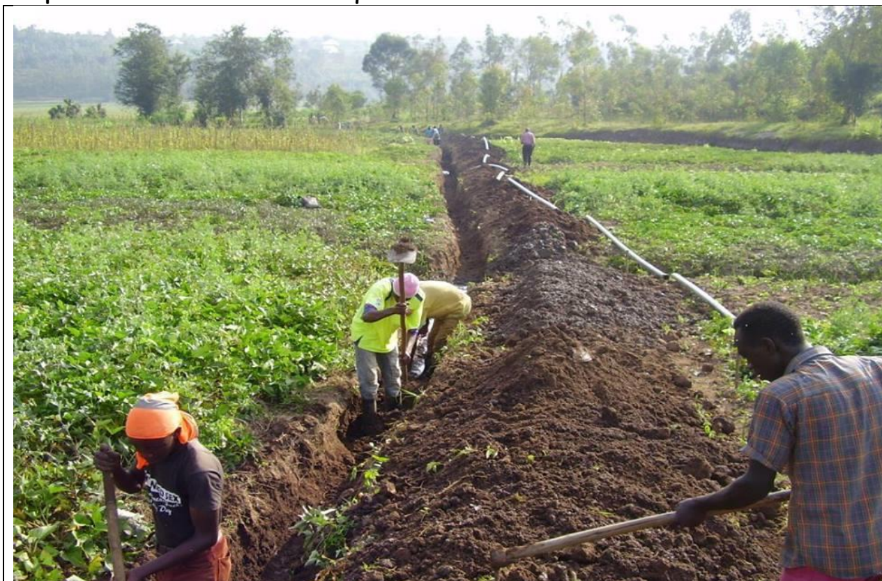
Posa condotte nel fondovalle
