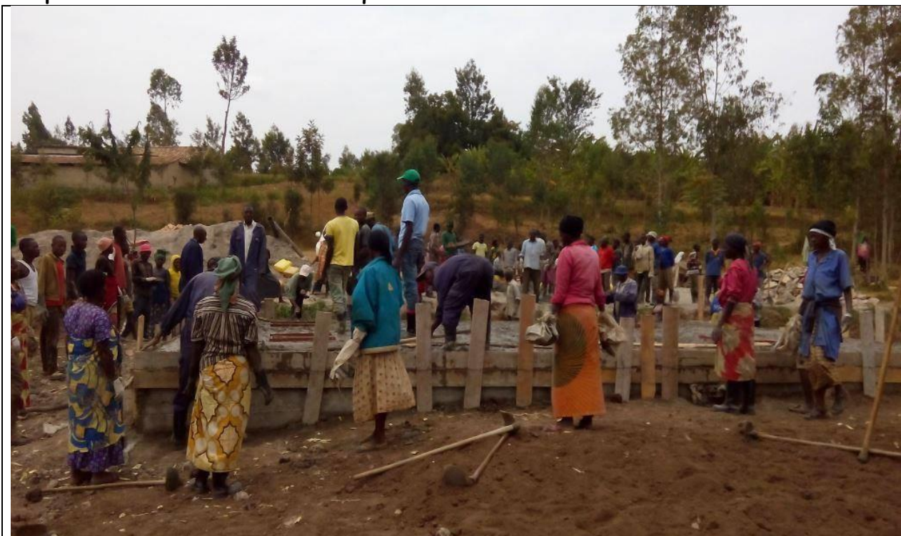
Costruzione di riserva e stazione di trattamento
