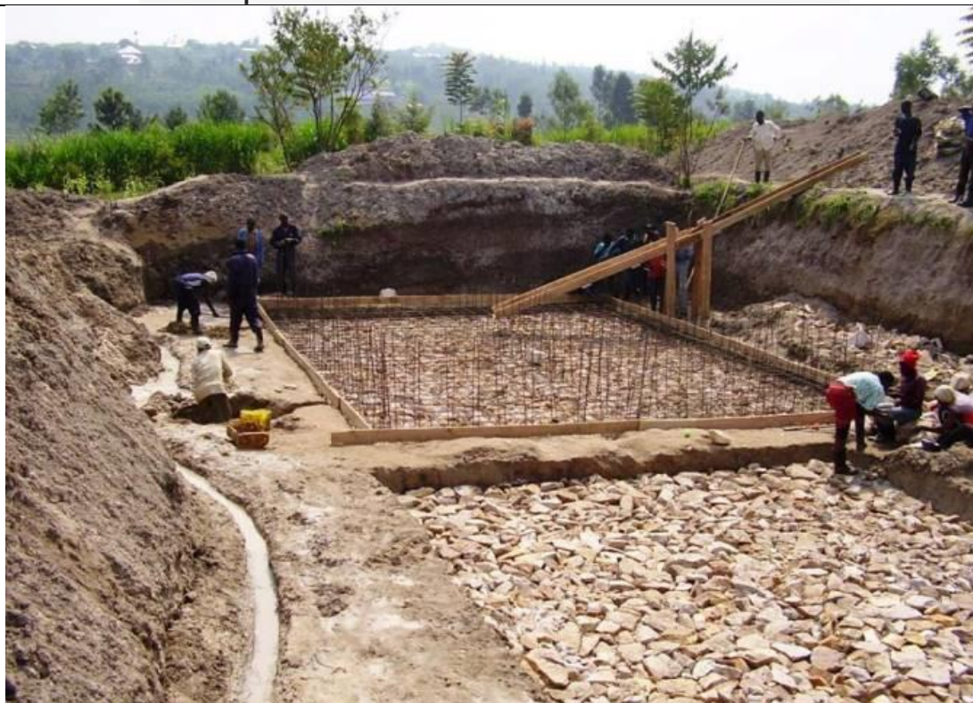
Costruzione di riserva e stazione di trattamento
