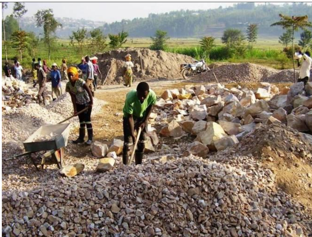
Costruzione di riserva e stazione di trattamento
