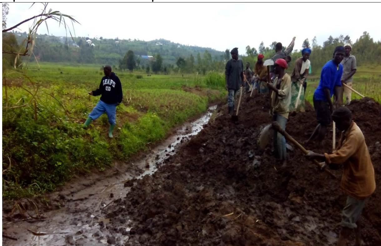
Captaggio delle sorgenti
