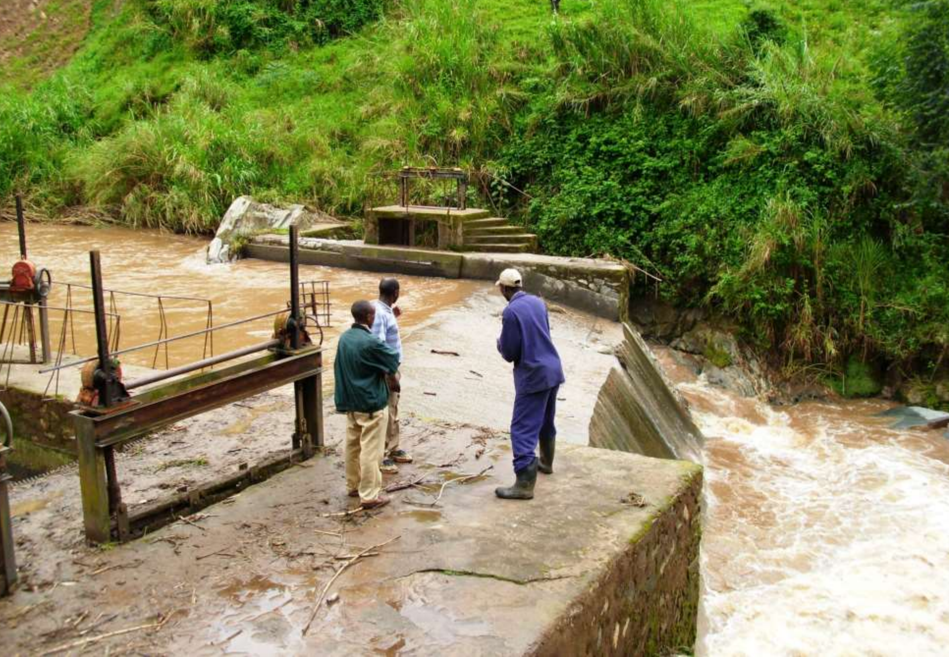
Opere di presa
