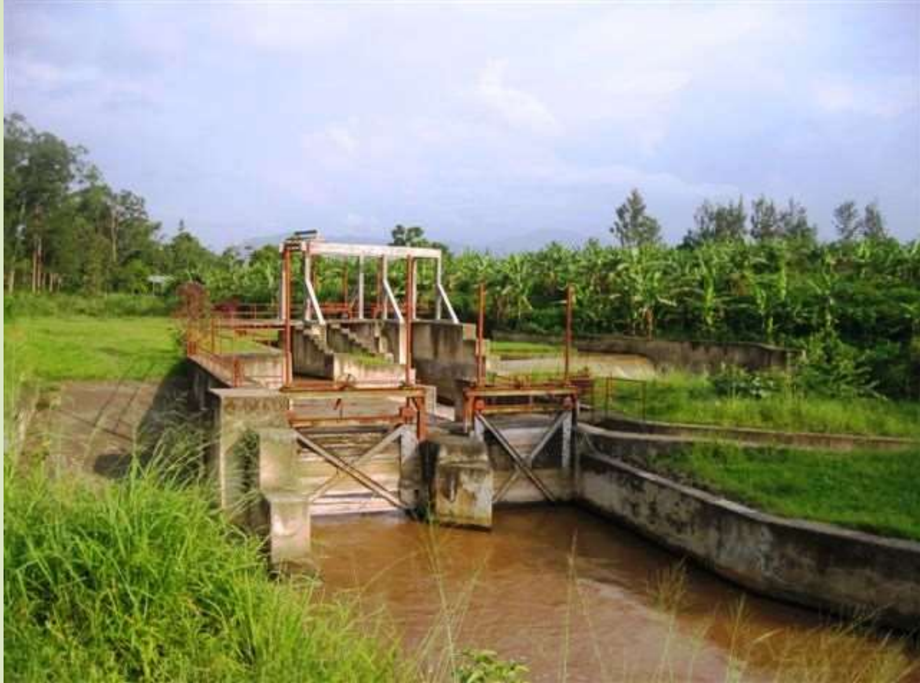
inizio canale di carico
