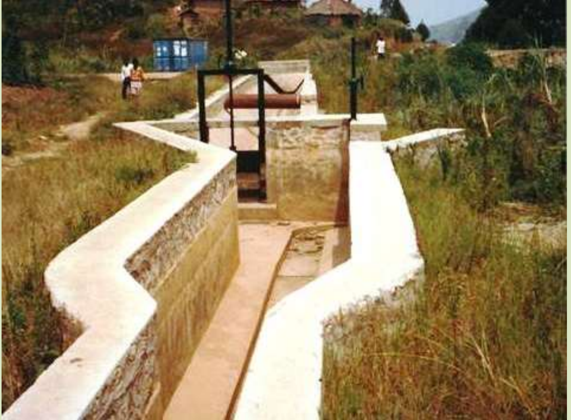
Inizio canale di carico
