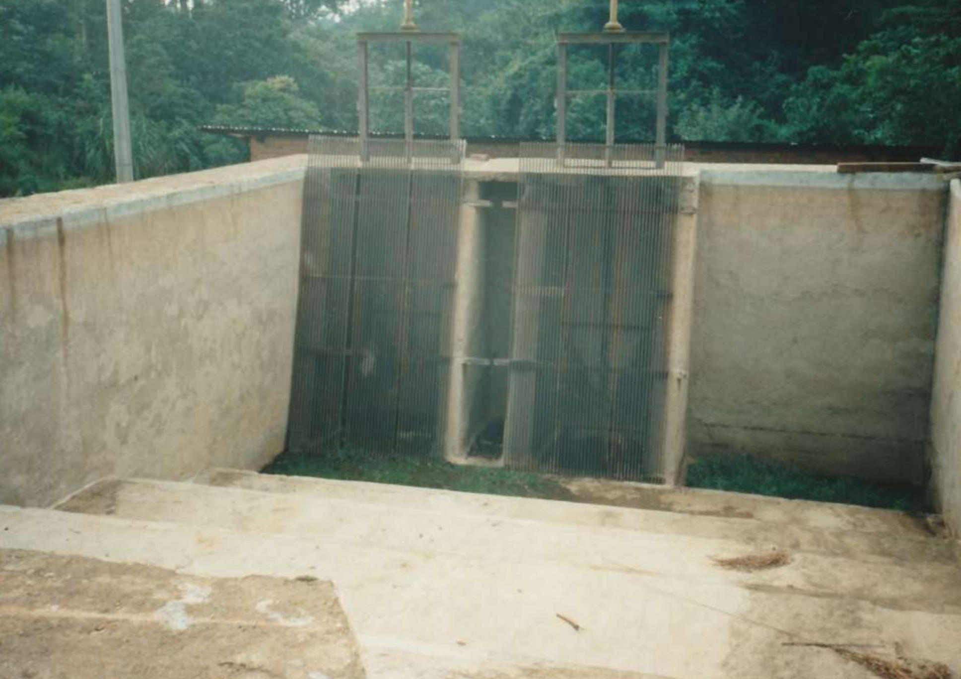
Vasca di carico
