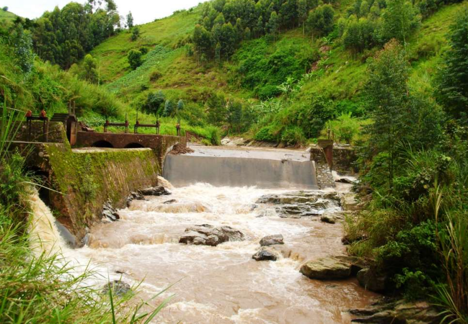
Opere di presa
