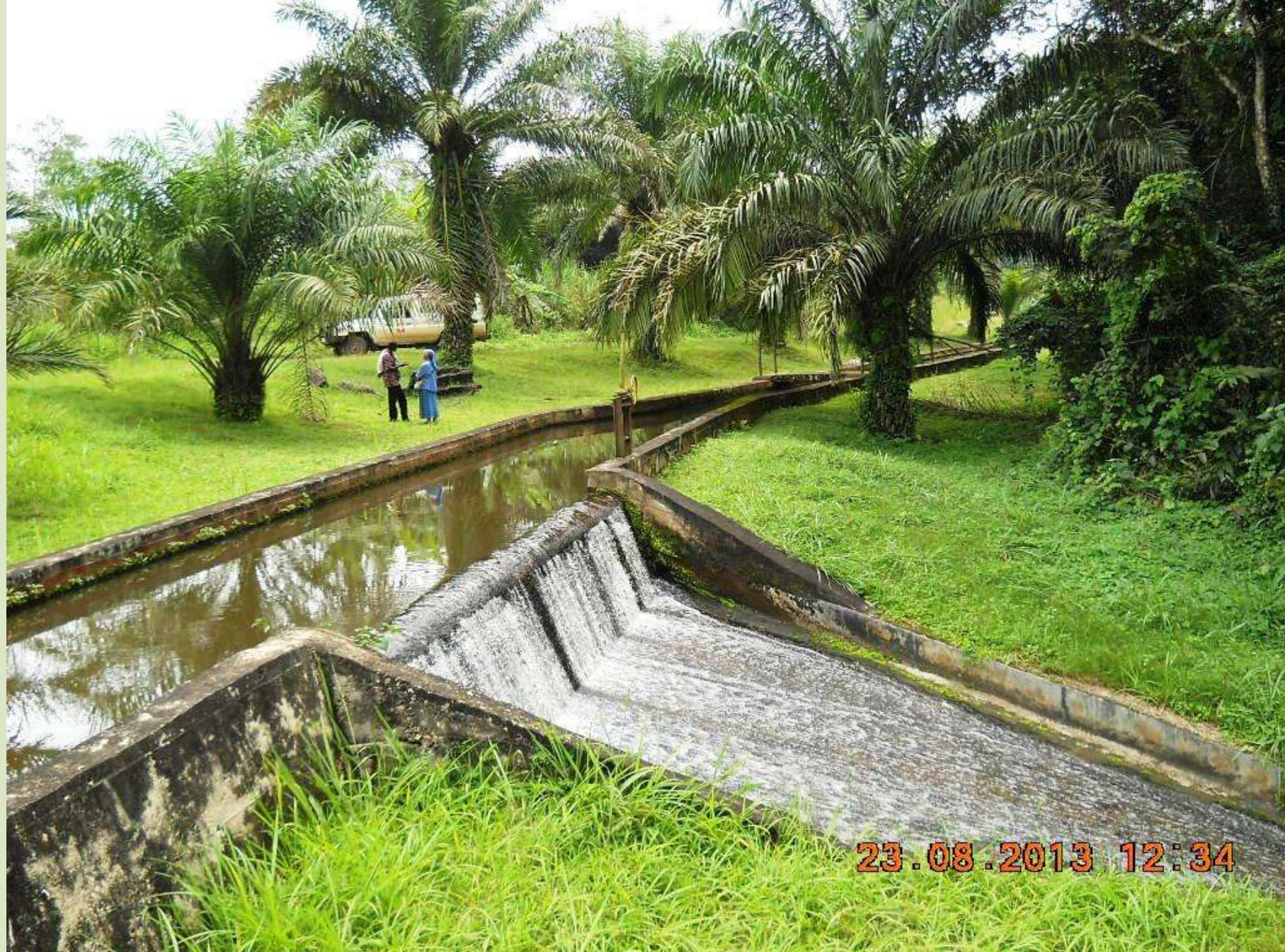
inizio canale di carico
