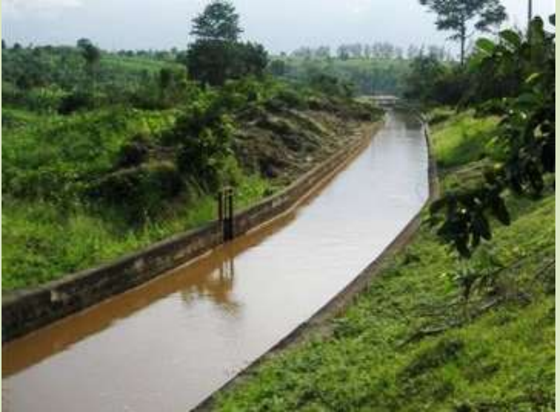
canale di carico
