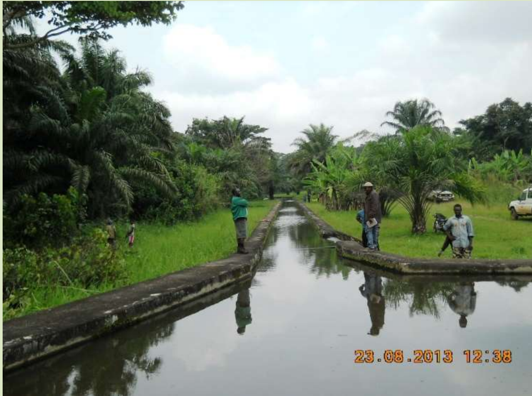
fine canale di carico in vasca
