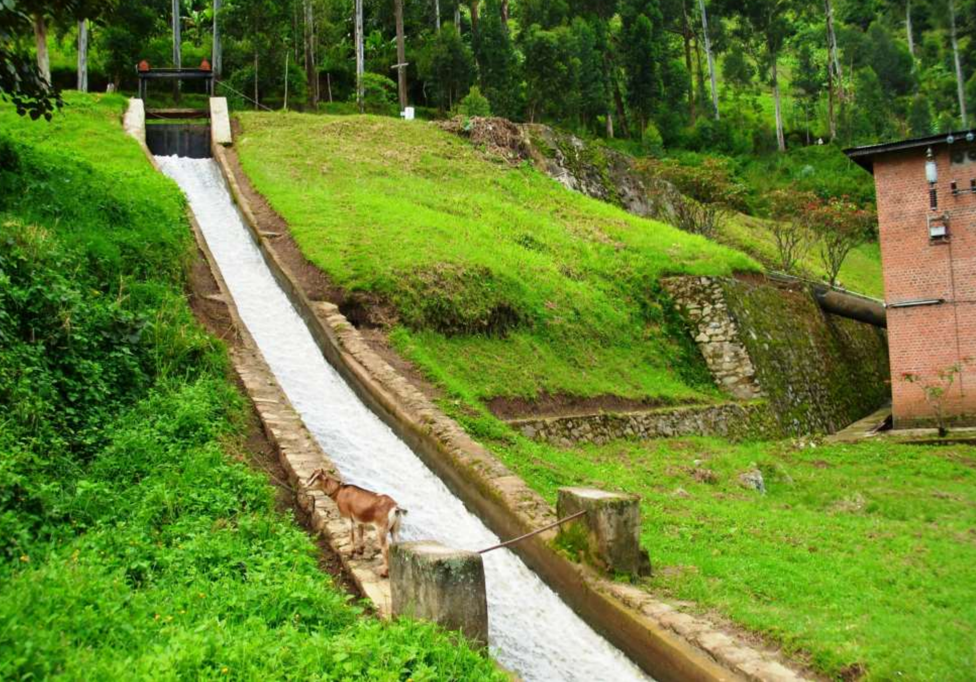
bacino di carico, condotte e troppo pieno
