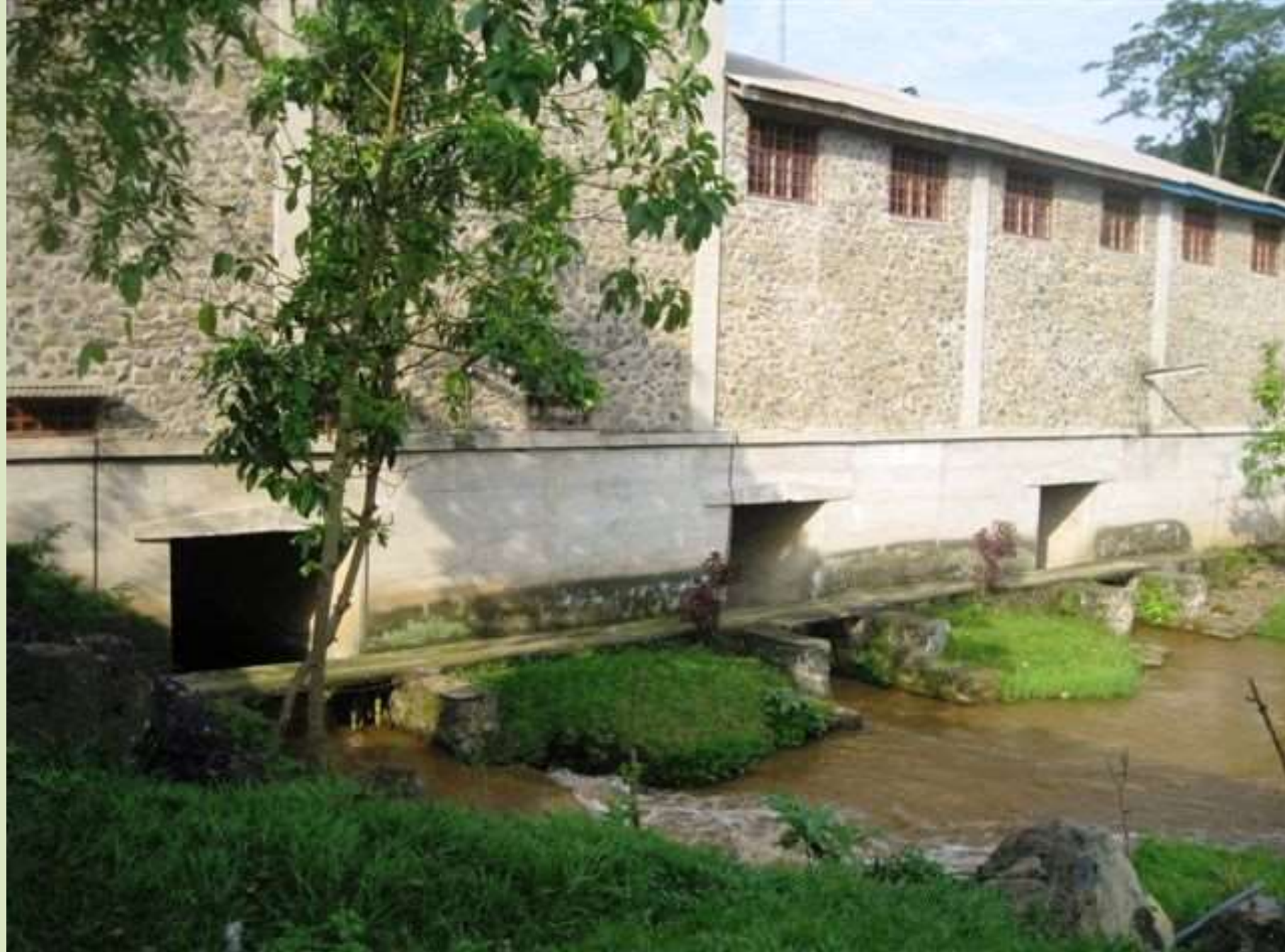
Canali scarico centrale lato fiume
