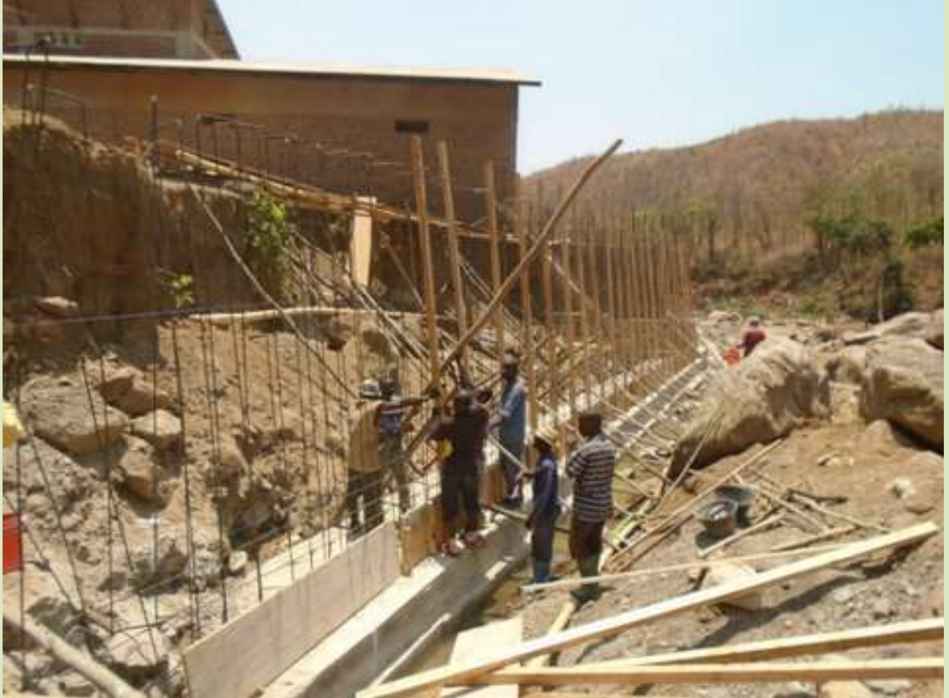
fondazione muro di protezione
