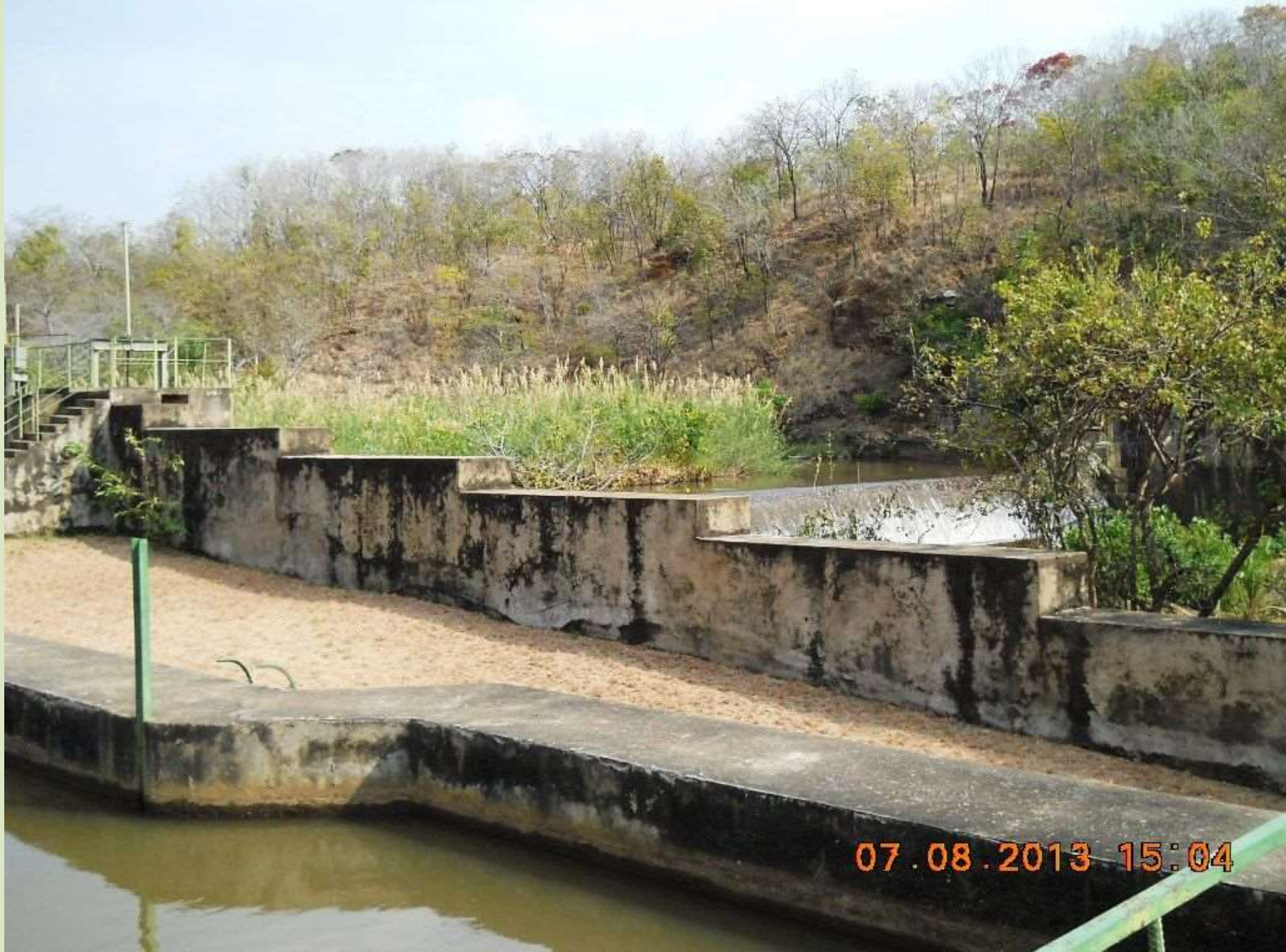
diga opera di presa
