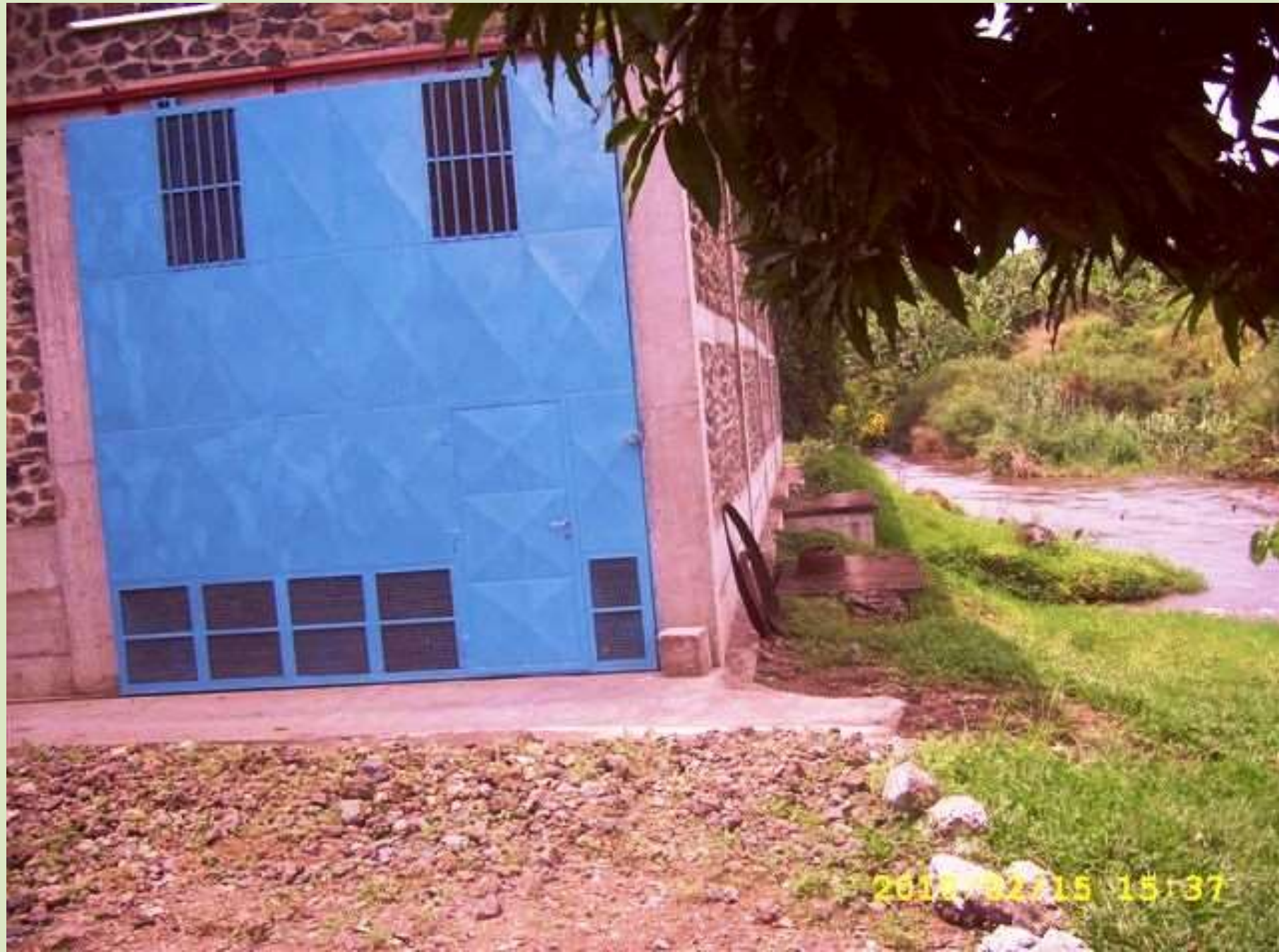
edificio GR4 lato fiume
