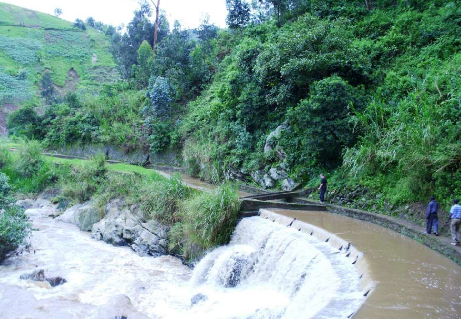
Canale di carico
